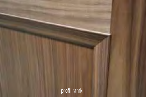
sposób łączenia panelu i opaski
