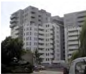
Apartamentowiec „Pelikan”, Poznań
