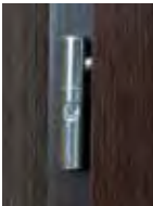
zawias czopowy wkręcany typ D
