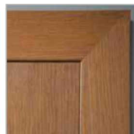
łączenie opasek pod kątem 45°
